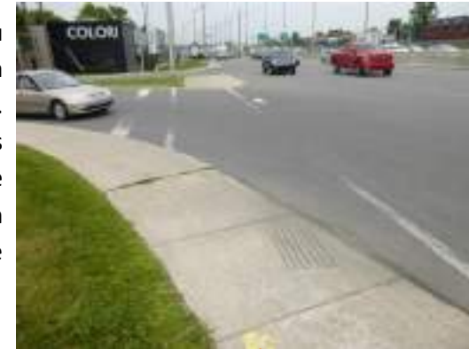
Figure 16 : Le passage pour piéton à l'intersection de la rue Gagnon et du chemin de la Côte de Liesse n'utilise pas le chemin le plus court exposant le piéton plus longtemps à la circulation.
