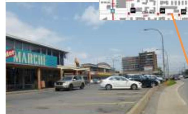
Figure 4 : Sur plusieurs tronçons, la marche ne peut être considérée comme agréable en raison des entrées charretières, du manque de végétation, des trottoirs étroits, de l'architecture et de l'entretien des immeubles peu intéressants.
