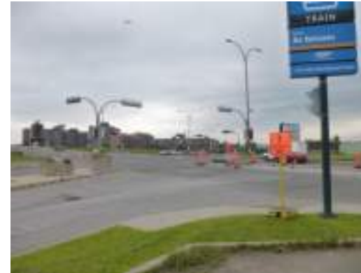
Figure 6 : La configuration de l'intersection des boulevards Henri-Bourassa et Jules Poitras n'est pas adéquate pour les piétons. On dénote entre autres des problématiques au niveau du bateau pavé sur la traverse nord, une interdiction de passer sur la traverse est, peu de temps pour la traverse piéton au coin sud-est de l'intersection, des lignes d'arrêt et des priorités piétonnes non respectées.
