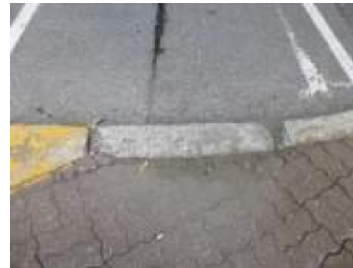
Figure 9 : Comme ce bateau pavé se trouvant à l'intersection des boulevards Côte-Vertu et Jules Poitras, plusieurs bateaux pavés présentaient des problèmes au niveau de l'accessibilité.
