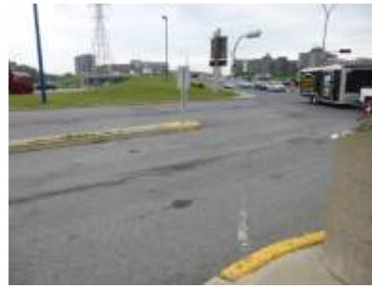
Figure 7 : Lors de l'étude, le bateau pavé de la traverse nord n'était pas aligné avec le passage piéton presque totalement effacé de l'intersection des boulevards Henri-Bourassa et Jules Poitras.
