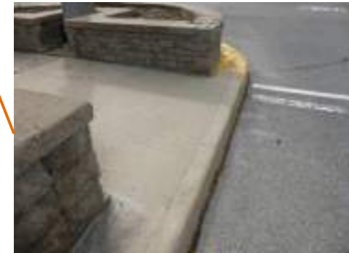
Photo 5: Absence de bateau pavé au niveau du refuge pour piétons, à la traverse du boul. Poirier à l'est de l'intersection
