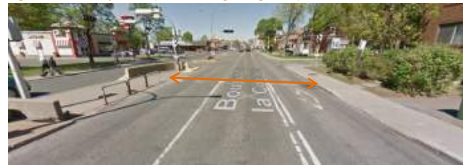
Figure 4 : L'intersection de Côte-Vertu et de Cardinal présente une incohérence au niveau des bateaux pavés, comme 22 autres traverses auditées dans le secteur. Ici, le bateau pavé n'est pas aligné avec la traverse piétonne. (Source de l'image : GoogleStreet)
